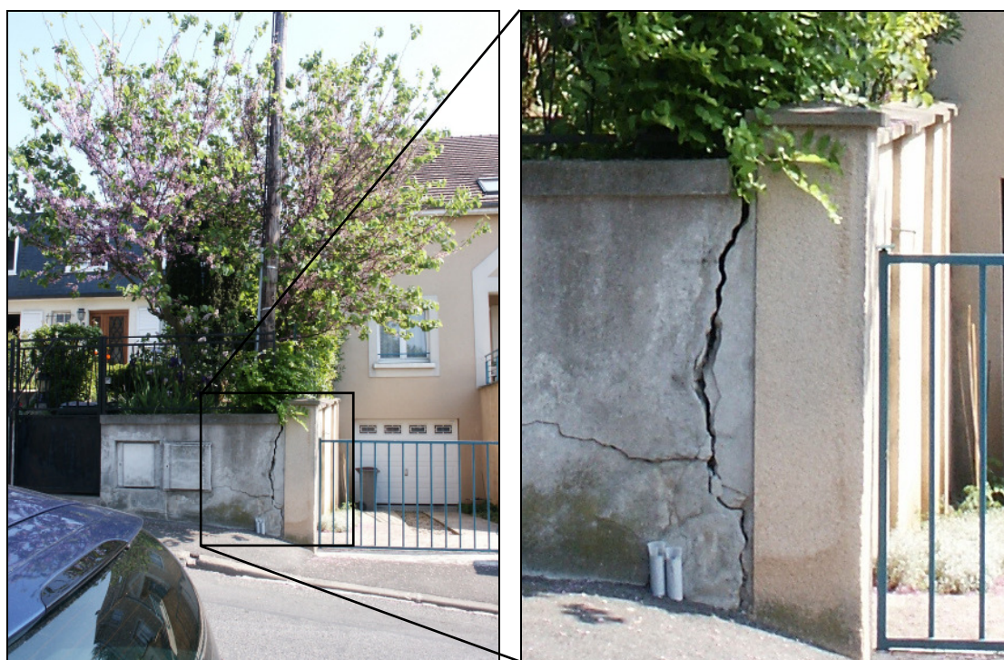
Position 1 : 38 Rue de l'Ormerai à Bry-sur-Marne, fracturation ; mais attention en ce cas un choc pourrait aussi expliquer ce type de déformation : une enquête de terrain auprès des habitants est nécessaire...
